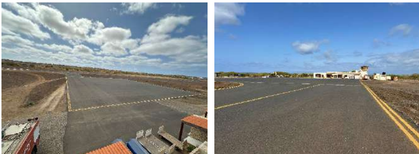
Figura 3. Plataforma de estacionamento de aeronaves
