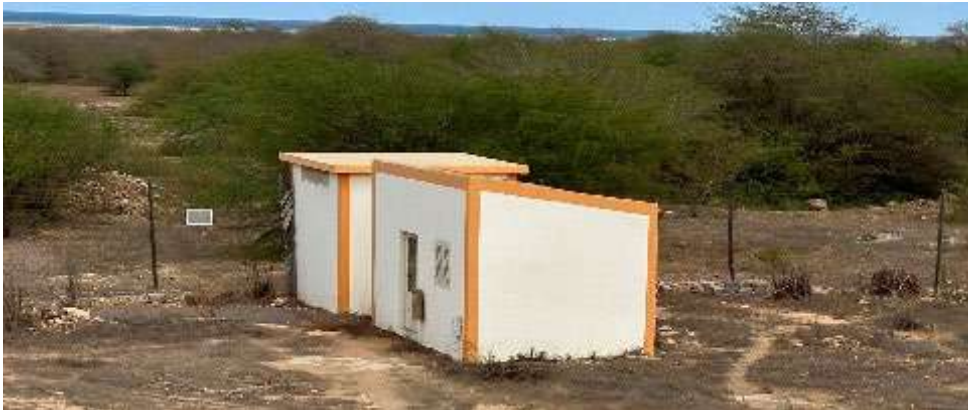
Figura 22. Central Elétrica e Fornecimento de Energia Elétrica
