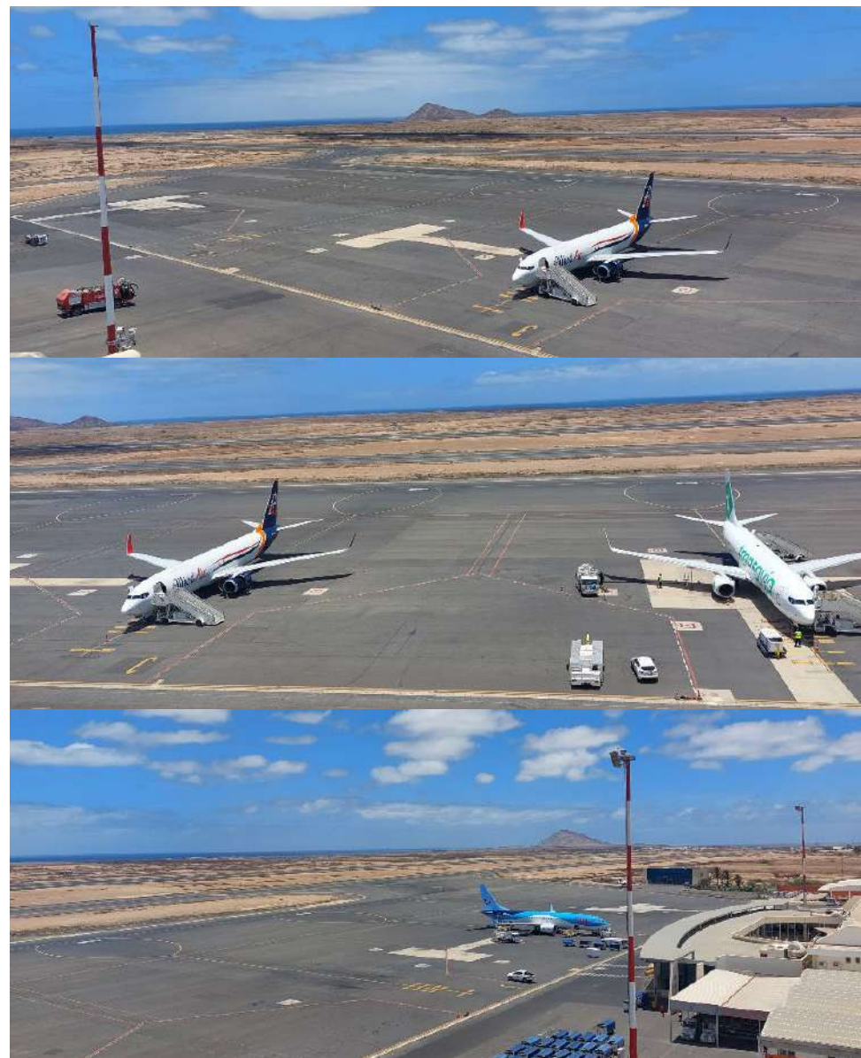
Figura 5. Plataforma de Estacionamento de Aeronaves
