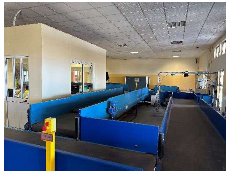
Figura 9. Edifício terminal – Partidas (Sistema de tratamento de bagagens - BHS)
