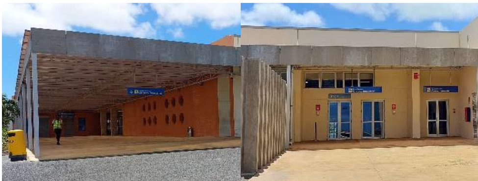
Figura 13. Edifício terminal – Chegadas (Acesso al edificio)
