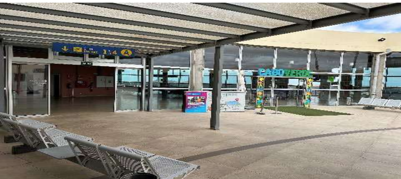
Figura 12. Edifício terminal – Partidas Internacionais (Sala de embarque)
