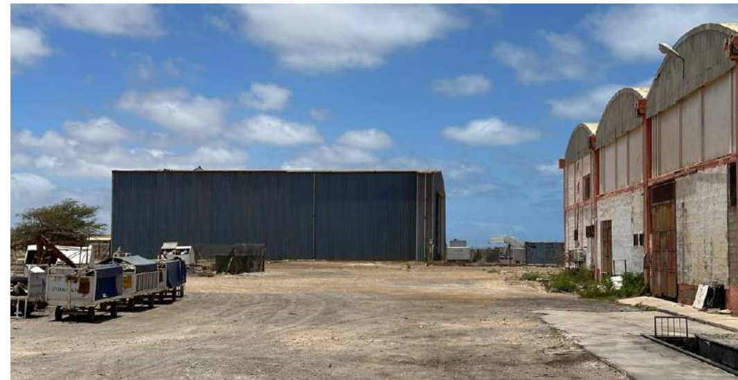
Figura 54. Edifícios em hangares e zona de equipamento abandonado
