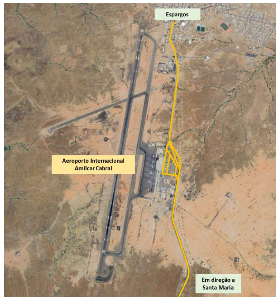
Figura 37. Acessos por estrada
