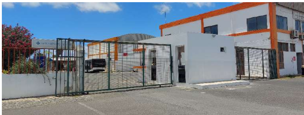
Figura 23. Acesso entre o lado terra e o lado ar
